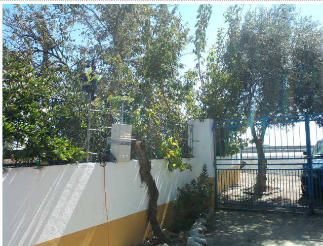
Figura 3 – Perspectiva do equipamento de medição de qualidade do ar durante as medições realizadas no local de medição M3 – Lanço E.
